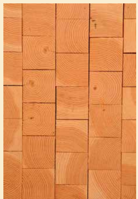
Bænkene præsenteres i et nyt showroom på Bondeskovgård ved Osted. Gulvet er lavet af endetræ af douglasgran skåret i stykker på 10x10x10 cm.
